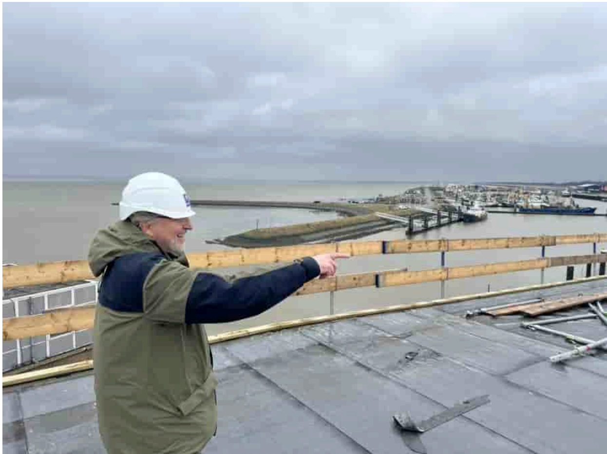
- Kuizenga op de bouwplaats
